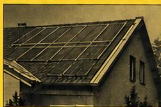
Solaranlage 1987 Selbst bauen – selbst nutzen
