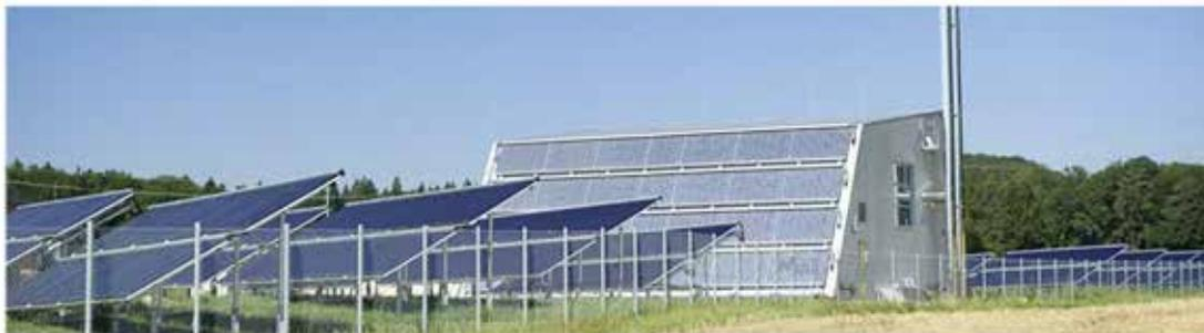
Heizzentrale umgeben von Solarthermiekollektoren. Quelle: solarcomplex AG
