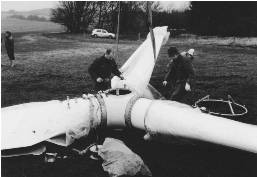
Hier wird der Rotor der V 27 montiert - damals (1994) imposant, aber aus heutiger Sicht fast wie Spielzeug.....
