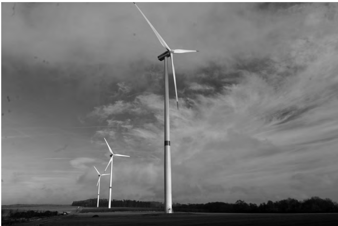
Drei neue WKA wurden in Merzig Merchingen errichtet
